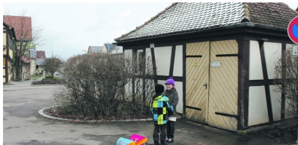
Die Schulkinder vom Verkehr der Hauptstraße wegzubringen ist der größte Nutzen der Umgestaltung des früheren Waaghäuschens. Mit dem Beginn der Arbeiten müssen sich die Ickelheimer noch etwas gedulden.
